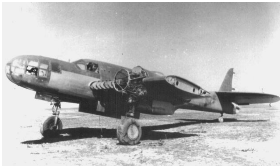
Estacionado, muy probablemente, en los terrenos de la Maestranza Aérea de Albacete, el Glenn-Martin 167F-2 nº 146 presenta este aspecto parcialmente desmontado. (Arráez)
